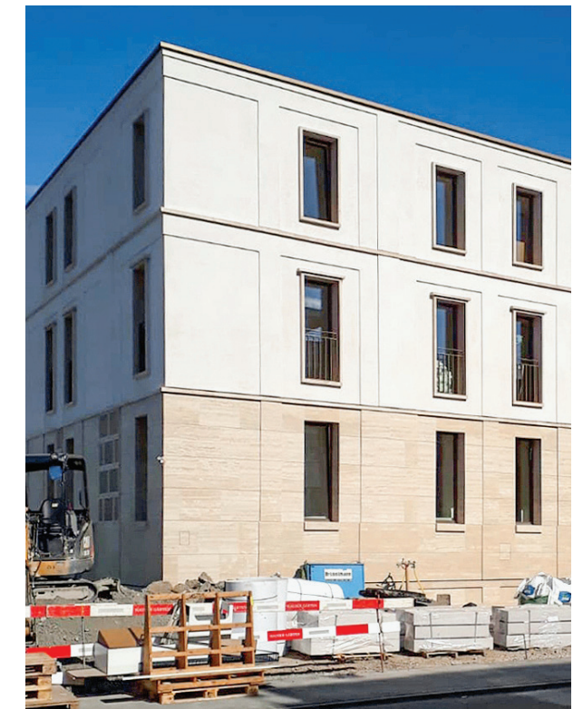
Fotos der Baustelle: Krapf AG
