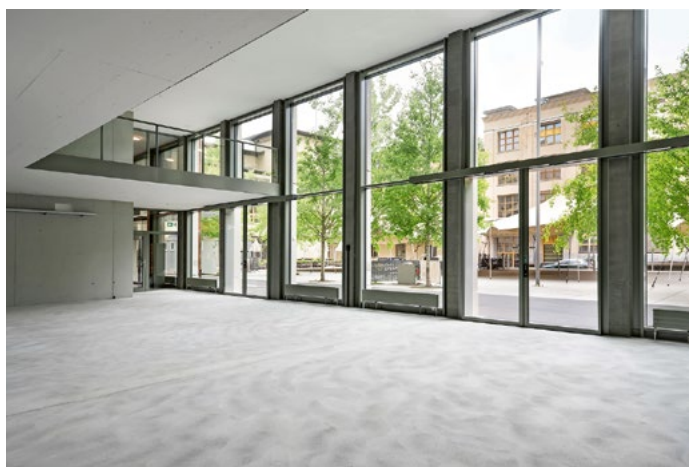
Die Regelgeschosse folgen einem klaren Stützenraster, das grosse, stützenfreie Zonen ermöglicht.
