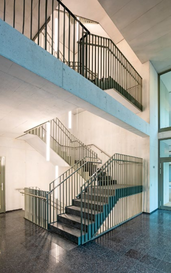
Ein durchgehender Betonkern fasst Treppen, Aufzüge und Sanitärzonen.
